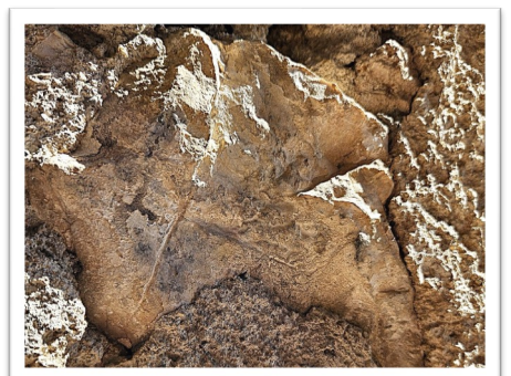
Via F. Rismondo, angolo curvilineo del muro che cinge l'orto Forziati, particolare della pietra con il sillabogramma I.
